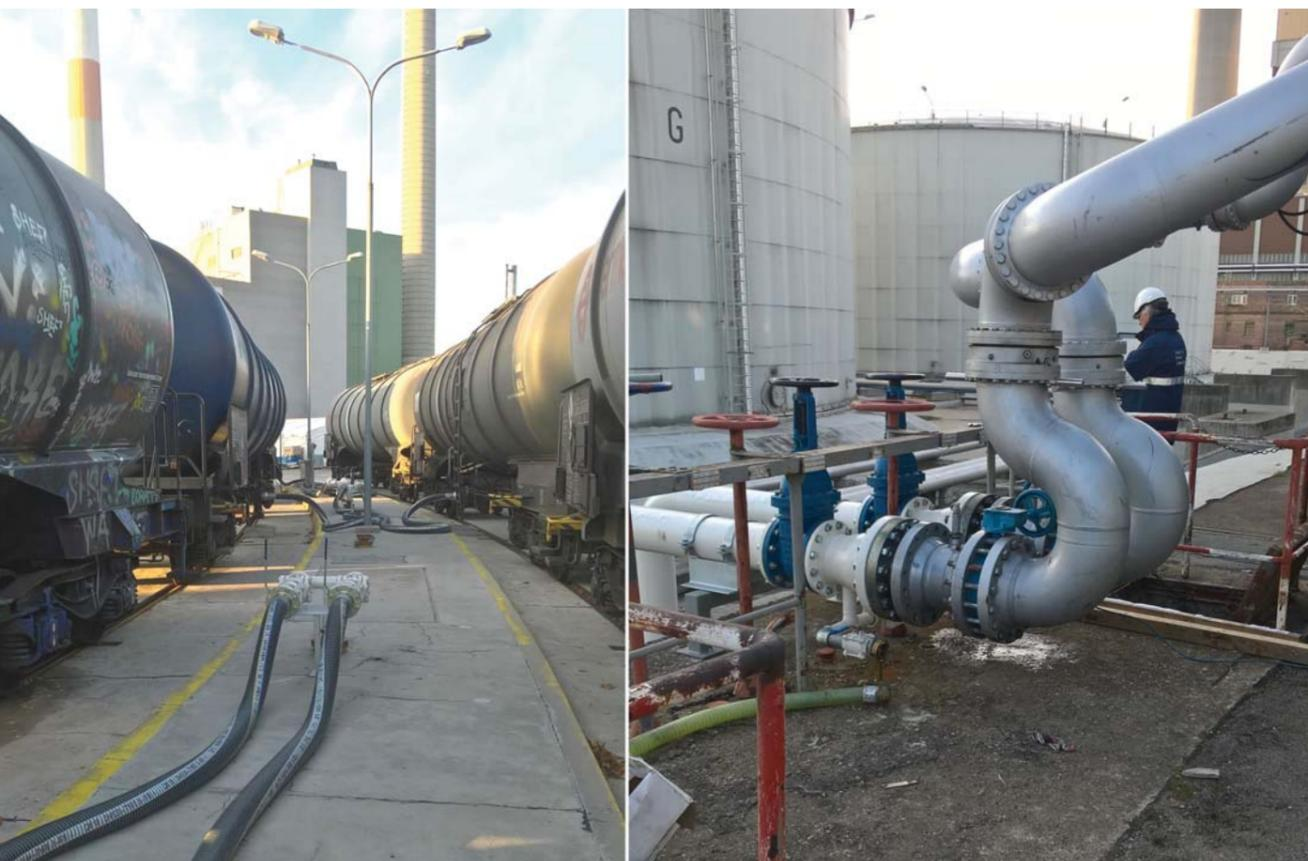
Abb.53: links: Entladung der Kesselwagen, rechts: Eichanschluss der Rohrprüfschleife
