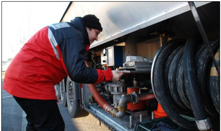
Revision einer Betriebsstoffmessanlage an einem Tankwagen
