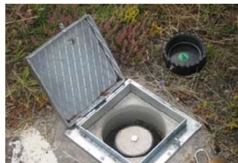
Abb. 2: Unterirdische Stabilisierung
