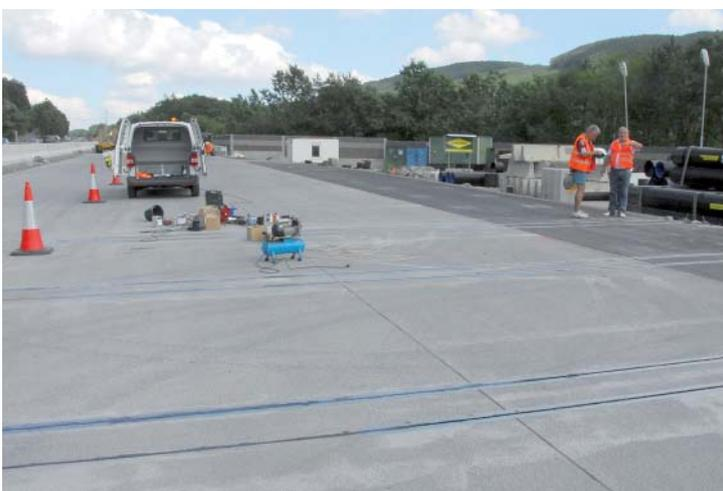
Eingießen der Piezosensoren in die Fahrbahn durch Mitarbeiter des Labors Kinematik im Straßenverkehr
